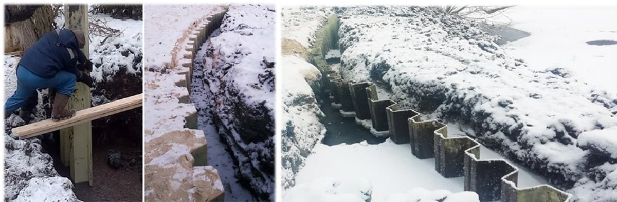
Рис. 6. Укрепление береговой линии водоема с помощью стеклопластиковых шпунтов «корытного» типа производства ФГУП «ВИАМ» в поселке городского типа Языково Корсунского района Ульяновской области
