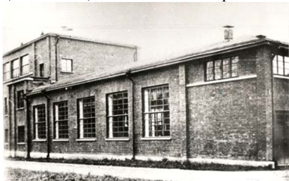
Рис. 2. Корпус Секции испытаний материалов (середина 20-х годов XX в.)
